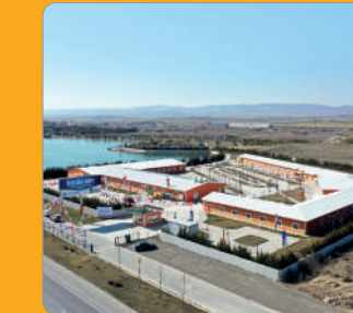
Özgür Köy Arındırma Merkezi
